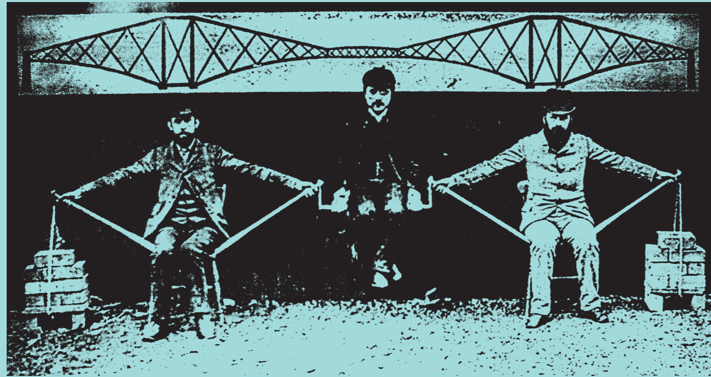
Forth of Firthin rakenteiden demonstrointi ja testaus.
