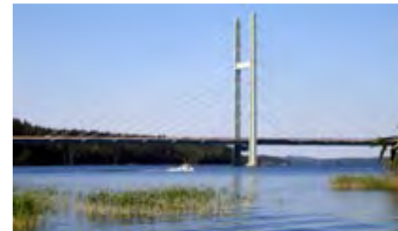
Heinolan tähti oli valmistuessaan 1993 Suomen suurin vinoköysisilta, 924 metriä pitkä ja 105 metriä korkea.
