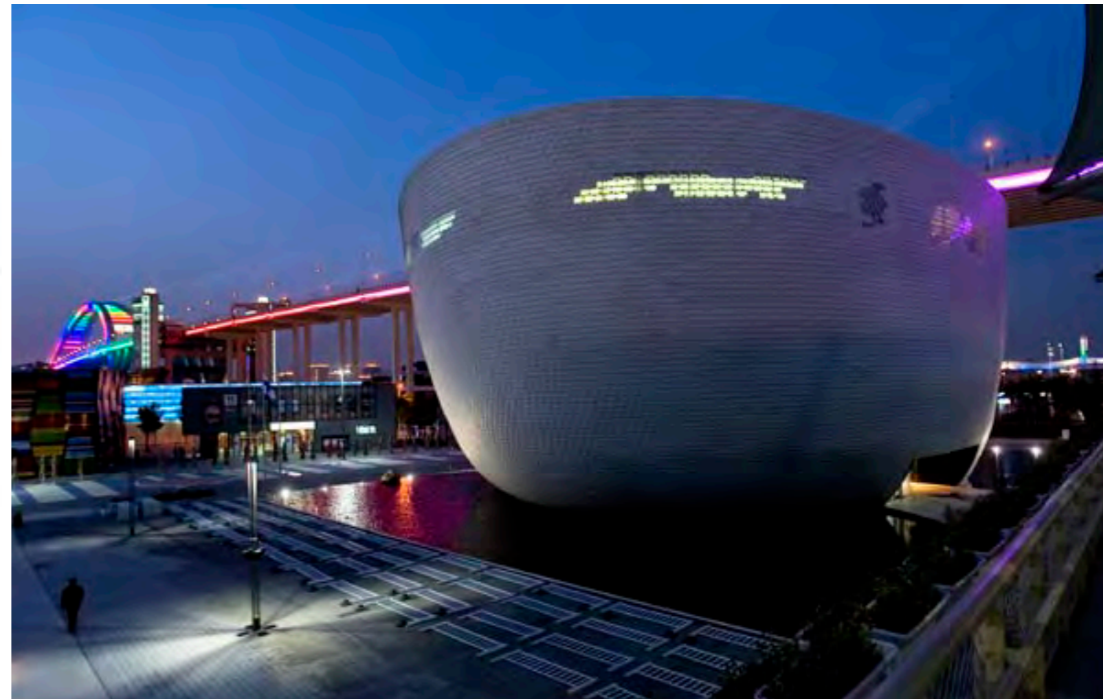
Kirnun julkisivun suomet on tehty muovi-paperi seoksesta, joka on paperiteollisuuden jätettä. Jäte on kierrätetty kehittämällä siitä uusi vedenkestävä rakennustuote.
