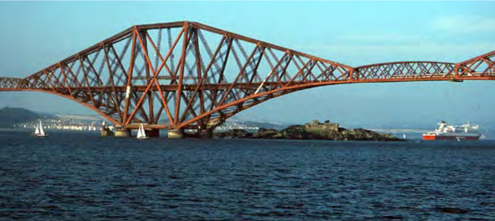
1883–1890 rakennettu, Firth of Forth Skotlannissa on yksi suurimmista ulokesilloista. Sen pääjätteiden mitat ovat 521 m.
