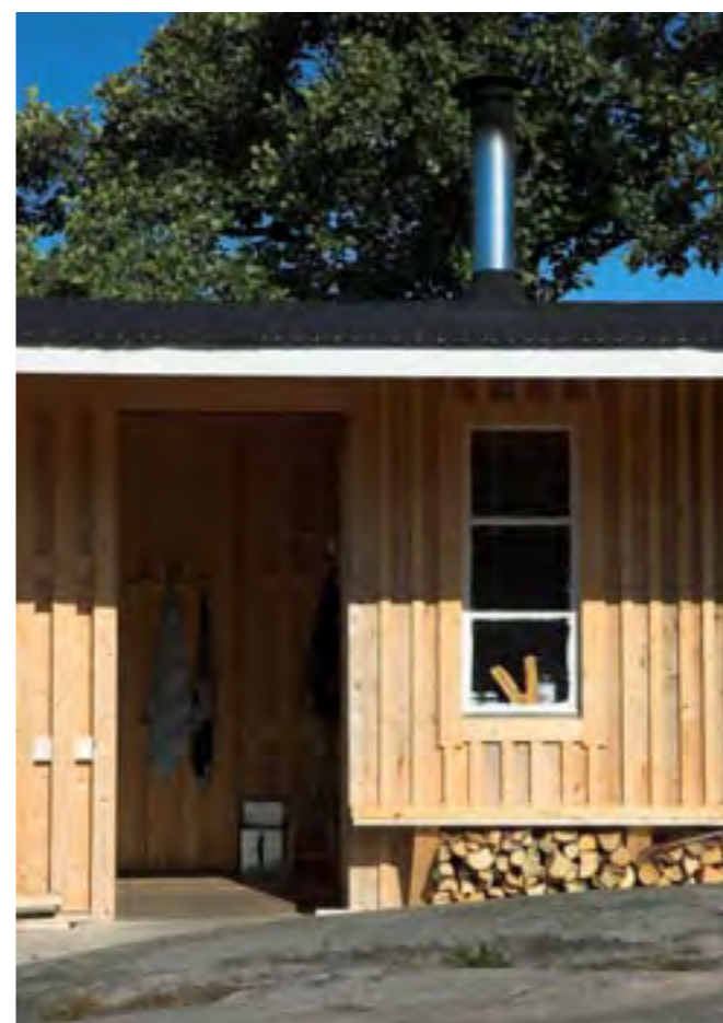
Hangon lintuaseman huolto- ja rengastuslaboratorio on tehty pääasiassa kierrätysmateriaaleista. Seinälaudat ovat peräisin talosta, joka purettiin jo 50 vuotta sitten. Nyt laudat ovat jo harmaantuneet.
