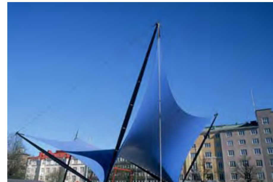
Lahden kauppatorilla sekä kesäisin että talvisin vieraileva katos hyppelee toripinnan yllä tuskin koskettaen sitä. Poistuessaan se jättää paikalle vain perustuskaivoja peittävät pyöreät teräslevyt. Arkkitehtitoimisto Roy Mänttari 2007.
