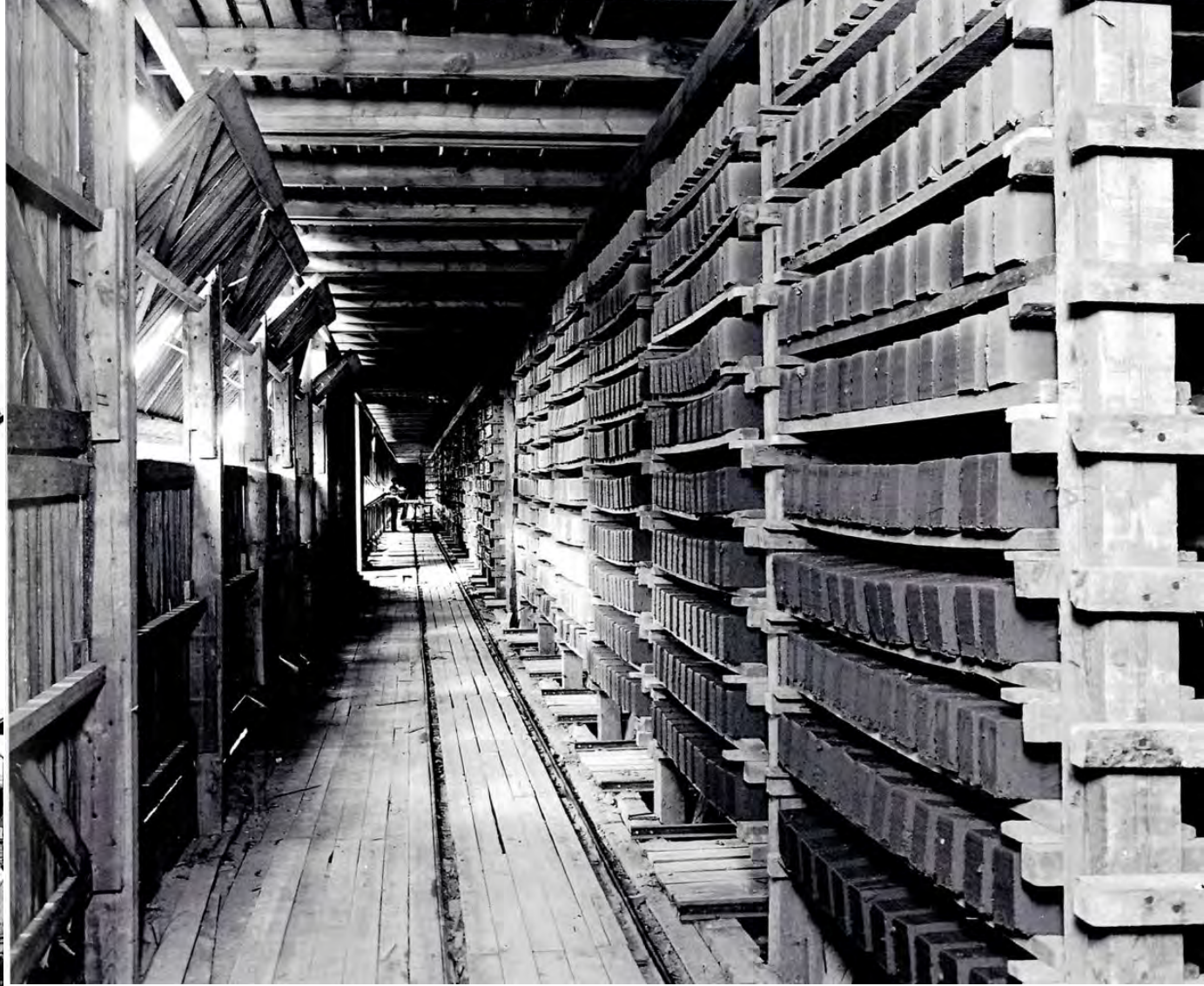
Tiilet kuivumassa kuivaamossa. Ilmankiertoa auttavat avattavat tuuletusluukut. J.Issakainen 2025.
